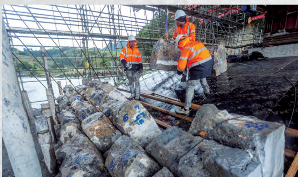
Gangak berreraikitzeo lanak Reconstrucción de las bóvedas
