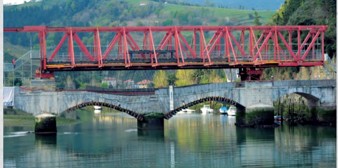
Auto-zinbria. Oinezkoentzako behin-behineko pasabidea jarri zen barruan Auto-cimbra. Provisionalmente se habilitó en su interior una pasarela para peatones
