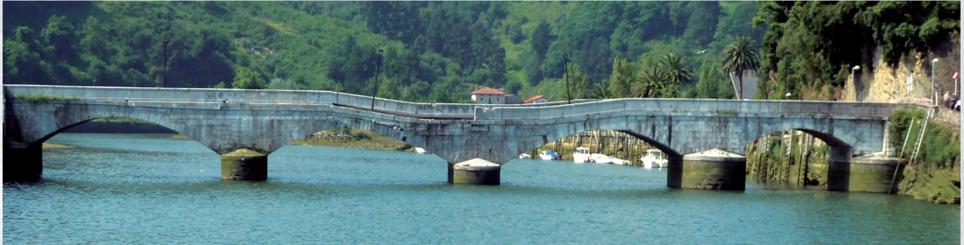
Zubia 2018ko uztailaren 5eko goizaldean bat-batean gertatutako kolapsoaren ondoren. Egurrezko piloteek ezin izan zioten eutsi pilaren pisuari. El puente tras el colapso súbito producido la madrugada del 5 de julio de 2018. Los pilotes de madera no pudieron resistir el peso de la pila.
