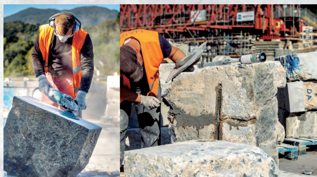
Harlandu berriak prestatzen eta zaharrak konpontzen Preparación de sillares nuevos y reparación de los antiguos
