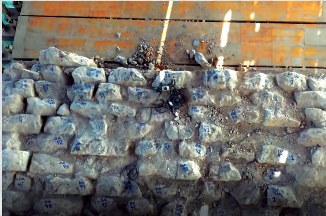
Desmuntatzeko zenbakiu egin zituzten dobelak Dovelas numeradas para su desmontaje
