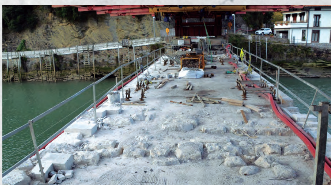
Obraren azken fasea Fase final de obra
